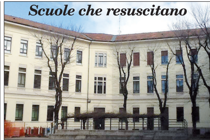
Madame Bodio, Scuola Primaria Giacomo Leopardi, torna al suo antico splendore: finiti i lavori, tolti i vandalismi, torna ad essere l'elegante edificio che era. (Foto di Antonella Loconsolo)
