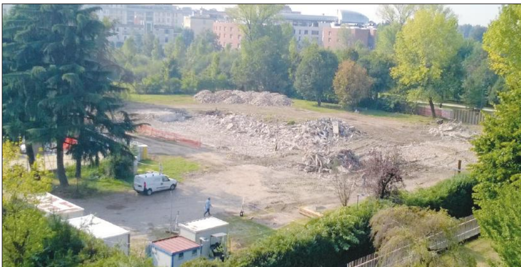
L'abbattimento della vecchia Cassinis si è concluso da diversi giorni. Sono state smaltite anche le macerie. I lavori stanno procedendo bene. Adesso si attende la fase di ricostruzione, che sarà eseguita dalla stessa ditta che ha lavorato finora.
